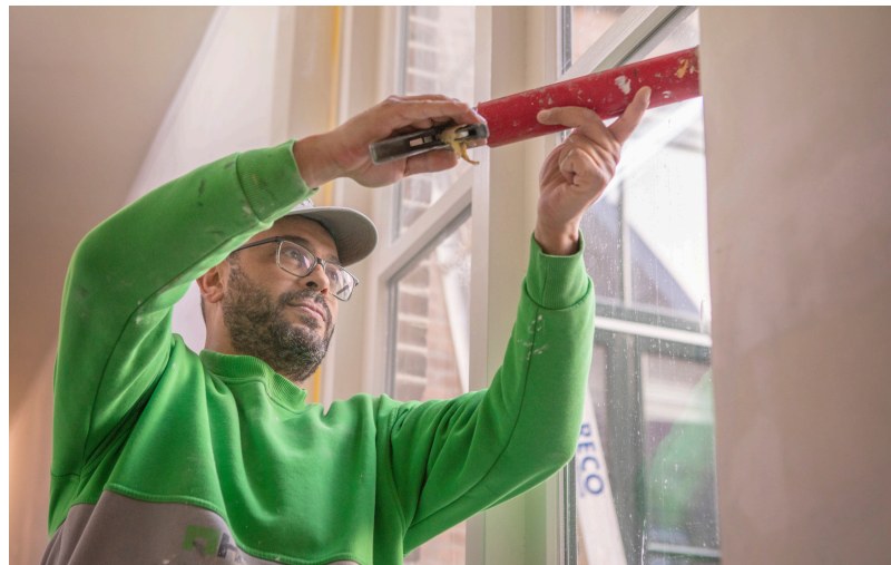
*HR++ glas wordt geplaatst en afgekit
