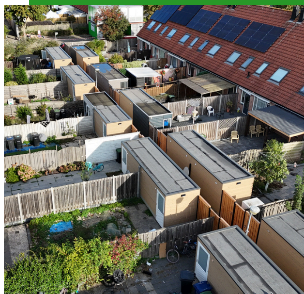
*Een deel van de al vervangen bergingen.
