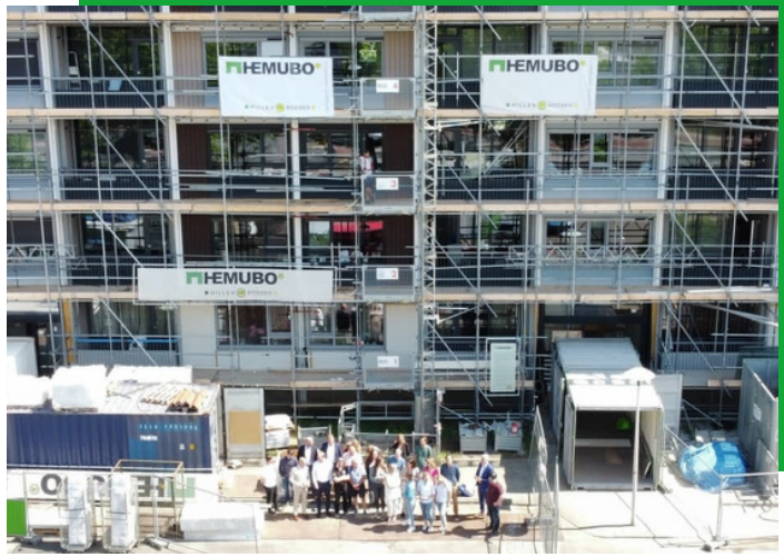
*De bouwwerkzaamheden in volle gang
