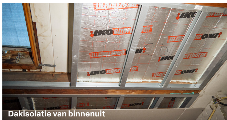
Alle voorgezaagde isolatieplaten worden gemerkt
