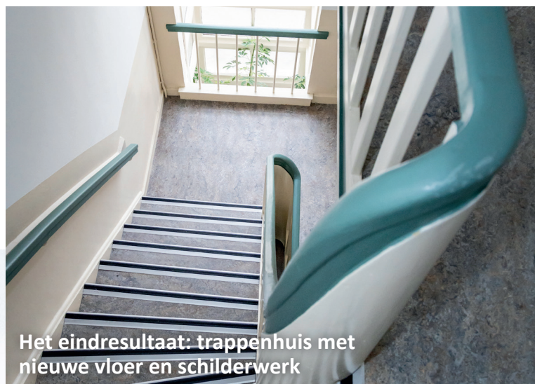
Schilderwerk in het trappenhuis
