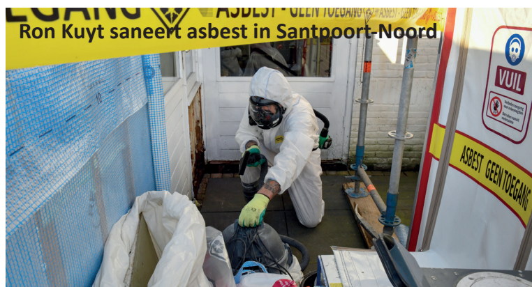
Werkzaamheden aan de woningen
